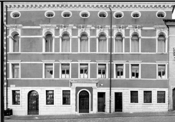
1) Vista da Corso Garibaldi
