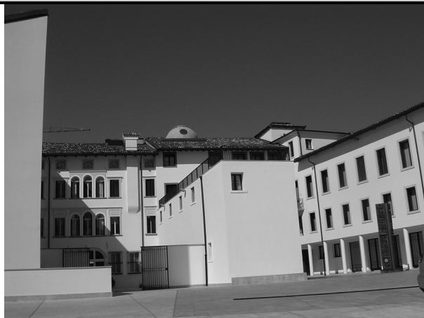
1) Vista da cortile interno
