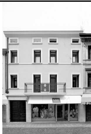
1) Vista da Corso Garibaldi
