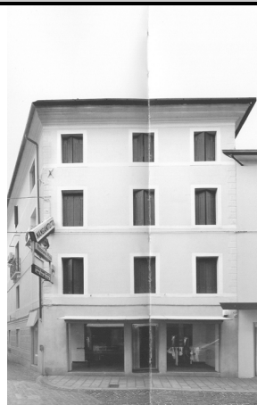
1) Vista da Corso Garibaldi
