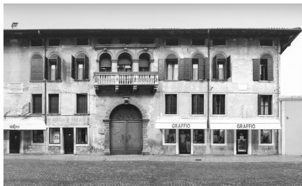
1) Vista da Corso Garibaldi
