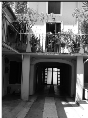
1) Vista dalla corte interna
