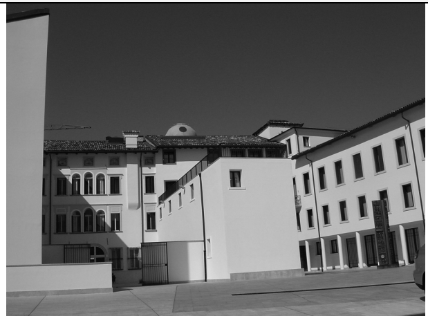
2) Vista da cortile interno
