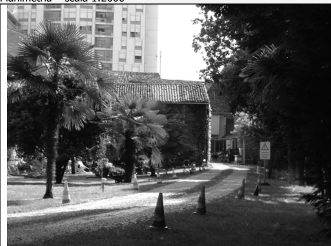
2) Vista dal giardino retrostante
