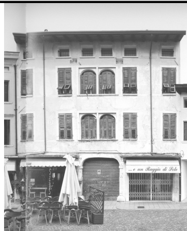
1) Vista da Corso Garibaldi
