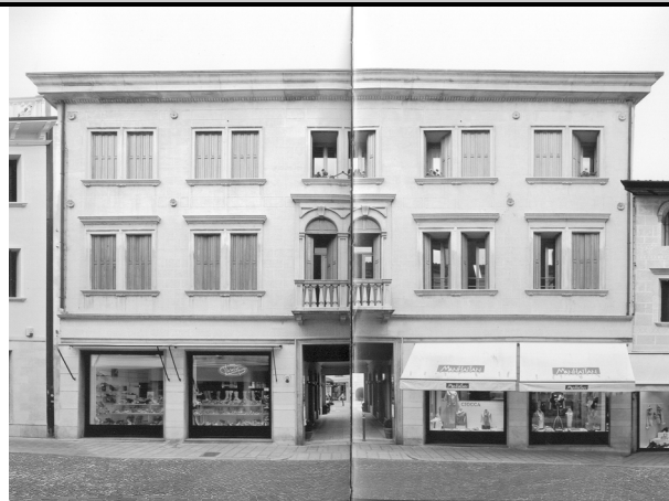
1) Vista da Corso Garibaldi
