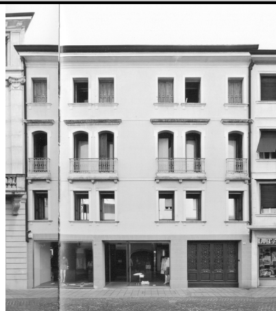
1) Vista da Corso Garibaldi
