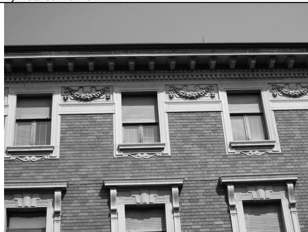
3) Particolare di facciata
