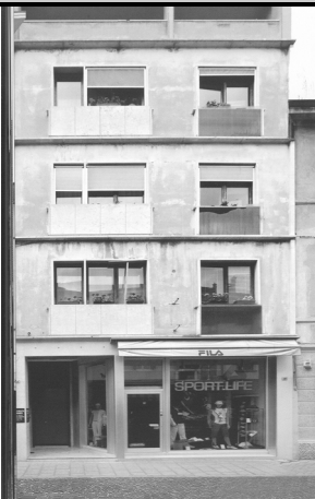
1) Vista da Corso Garibaldi
