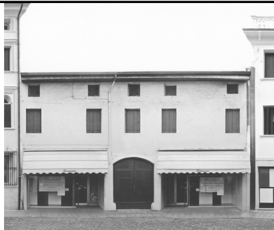
1) Vista da Corso Garibaldi
