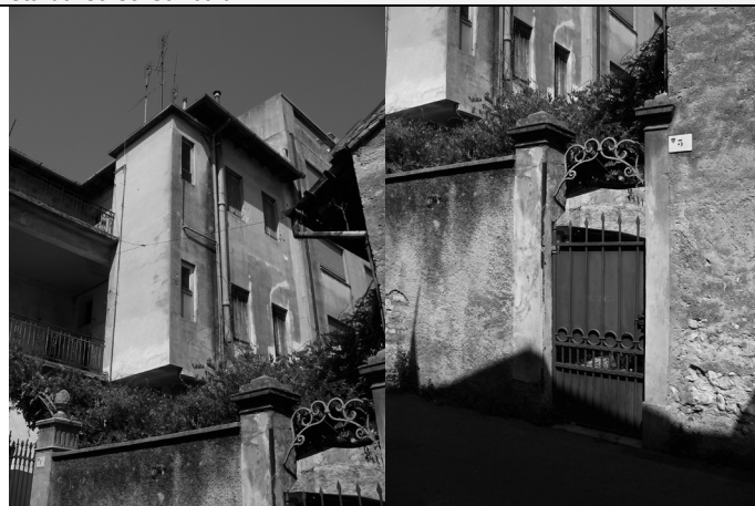
3) Viste su via San Giorgio
