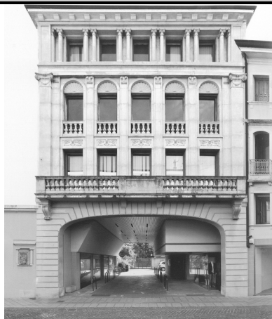
1) Vista da Corso Garibaldi
