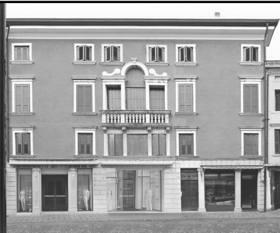
1) Vista da Corso Garibaldi
