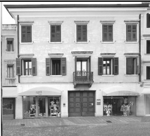
1) Vista da Corso Garibaldi
