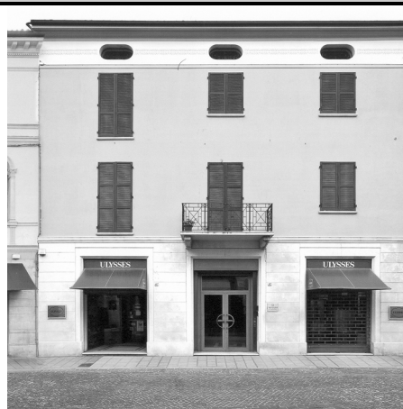
1) Vista da Corso Garibaldi
