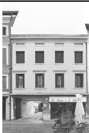
1) Vista da Corso Garibaldi
