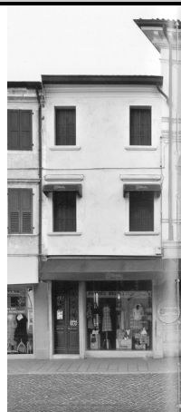
1) Vista da Corso Garibaldi
