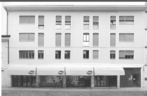
1) Vista da Corso Garibaldi
