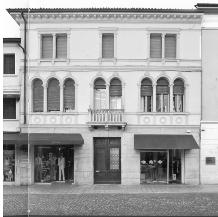
1) Vista da Corso Garibaldi
