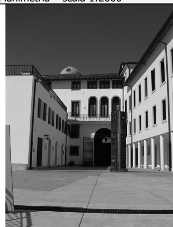
1) Vista della facciata dal cortile interno
