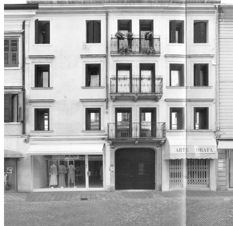
1) Vista da Corso Garibaldi
