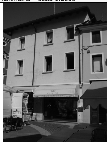
2) Vista piazzetta Cavour
