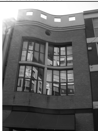
3) Particolare della facciata su via De Paoli
