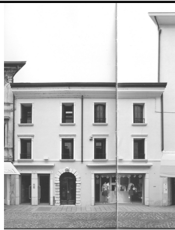
1) Vista da Corso Garibaldi
