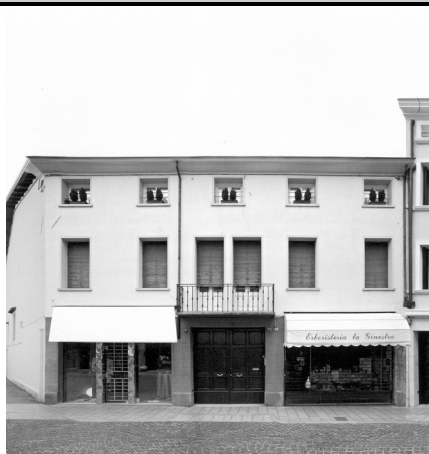
1) Vista da Corso Garibaldi
