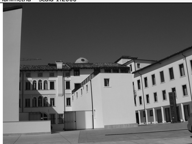
2) Vista da cortile interno
