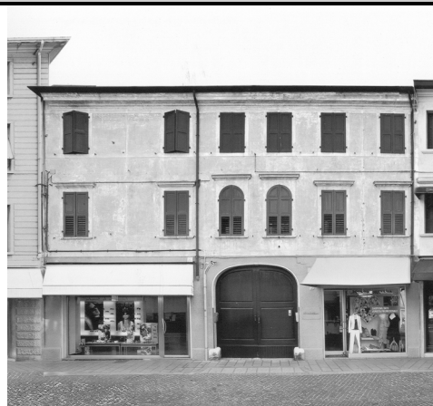
1) Vista da Corso Garibaldi
