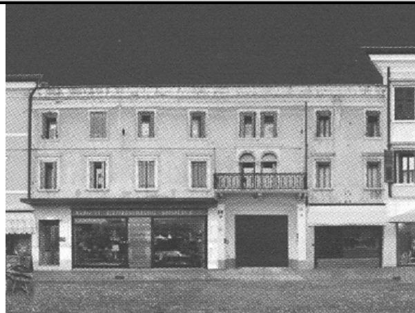
1) Vista da Corso Garibaldi
