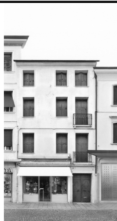
1) Vista da Corso Garibaldi
