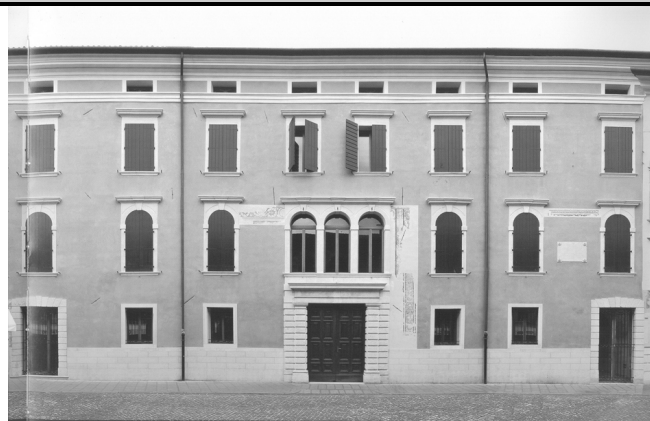
1) Vista da Corso Garibaldi
