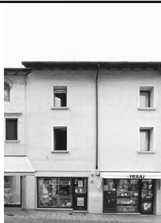
1) Vista da Corso Garibaldi
