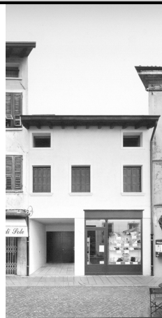
1) Vista da Corso Garibaldi
