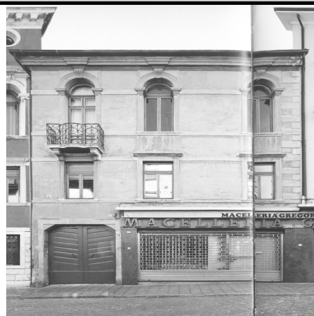
1) Vista da Corso Garibaldi
