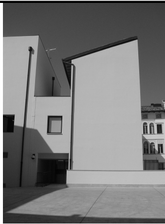
1) Vista da Corso Garibaldi
