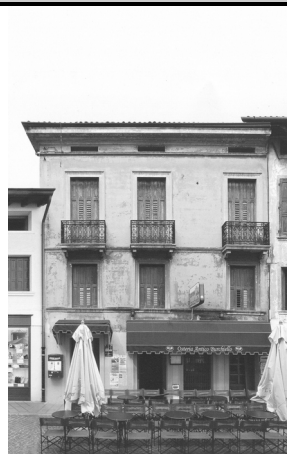
1) Vista da Corso Garibaldi
