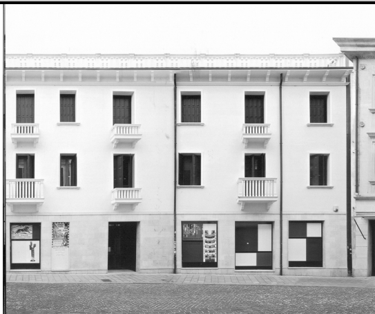
1) Vista da Corso Garibaldi
