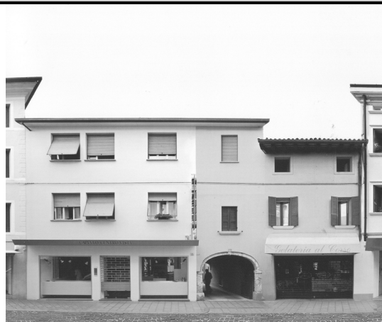
1) Vista da Corso Garibaldi
