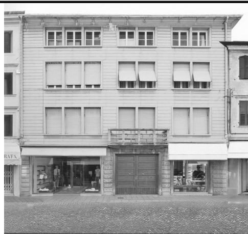
1) Vista da Corso Garibaldi
