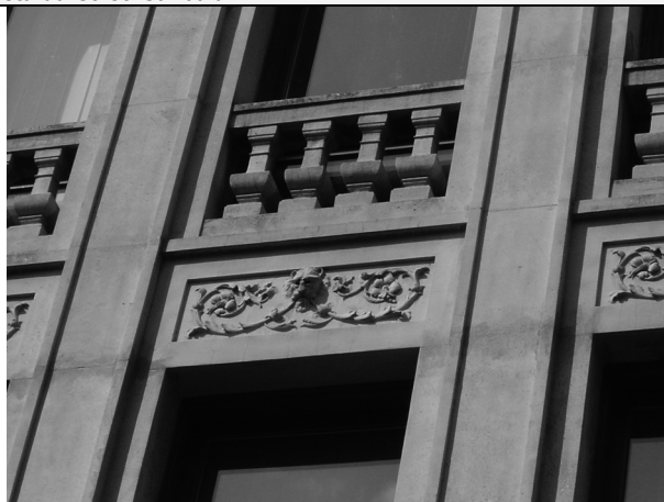
3) Particolare di facciata
