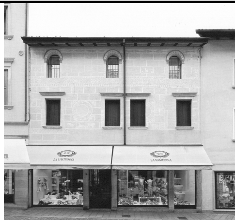
1) Vista da Corso Garibaldi
