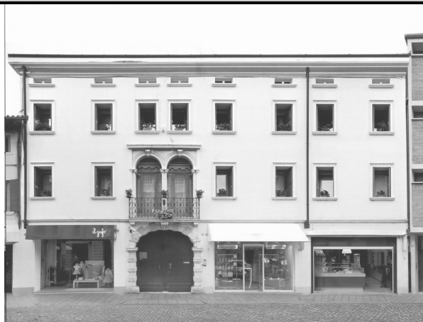
1) Vista da Corso Garibaldi
