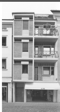
1) Vista da Corso Garibaldi
