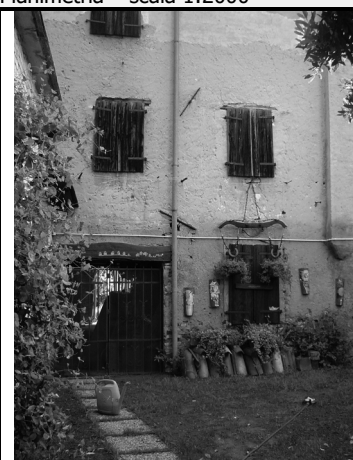
2) Vista dalla corte interna
