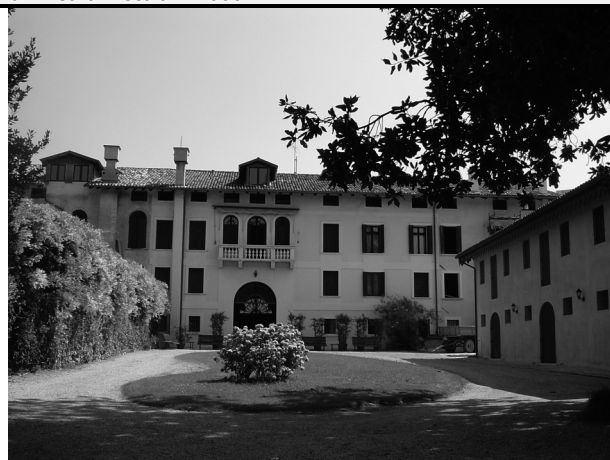
2) Vista da cortile interno
