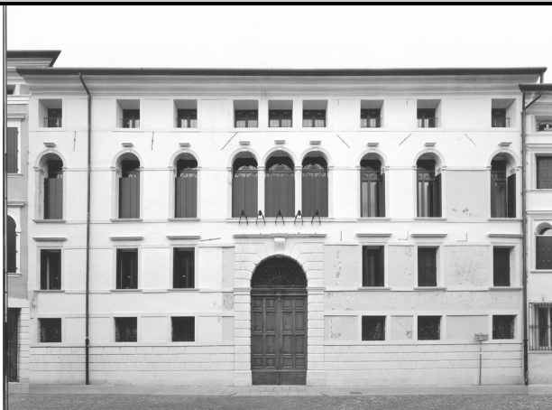
1) Vista da Corso Garibaldi
