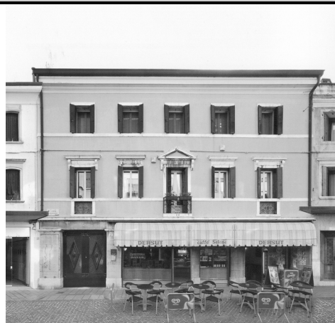
1) Vista da Corso Garibaldi
