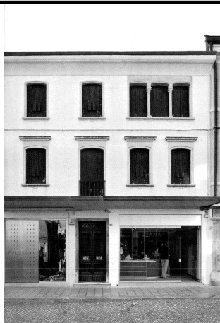
1) Vista da Corso Garibaldi
