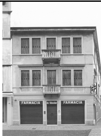
1) Vista da Corso Garibaldi
