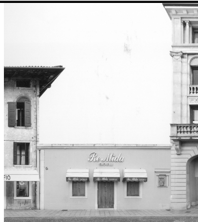
1) Vista da Corso Garibaldi
