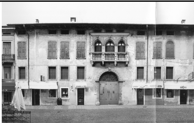
1) Vista da Corso Garibaldi
